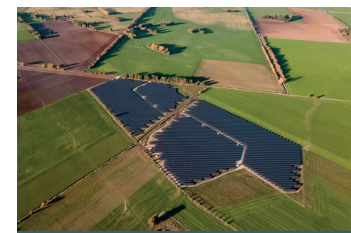
Solarpark Zobersdorf 2022, © BayWa-r.e.
